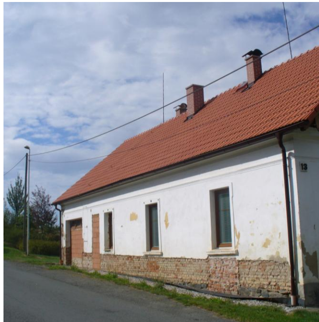
Budova po výměně
