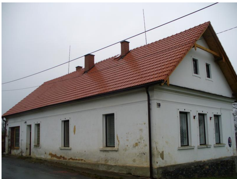
Budova OÚ před výměnou oken
