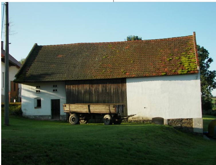
stodola před opravou
