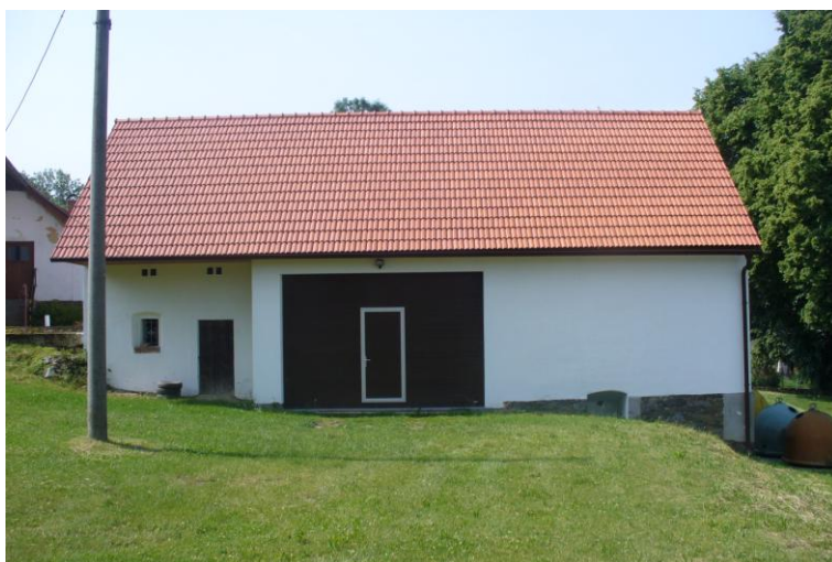
stodola po opravě
